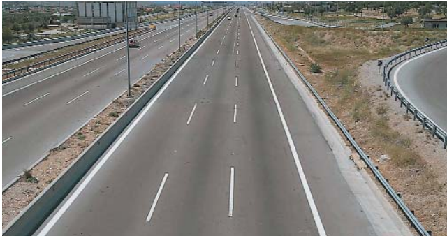
Σχ. 7.5α Αυτοκινητόδρομος.
